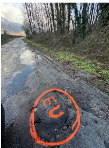
Repérage avant intervention de remise à la cote de tampon de visite
