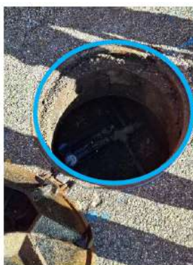
Vue sur l'arrivée d'un immeuble comprenant un regard avec un compteur de contrôle et un regard comprenant l'ensemble de compteurs individuels de l'immeuble
