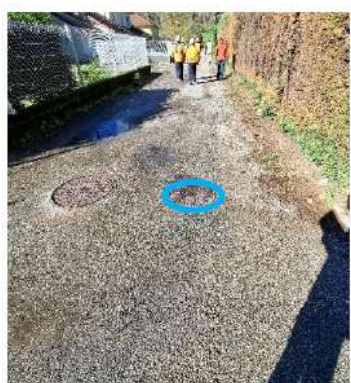
Vue sur l'arrivée d'un immeuble comprenant un regard avec un compteur de contrôle et un regard comprenant l'ensemble de compteurs individuels de l'immeuble
