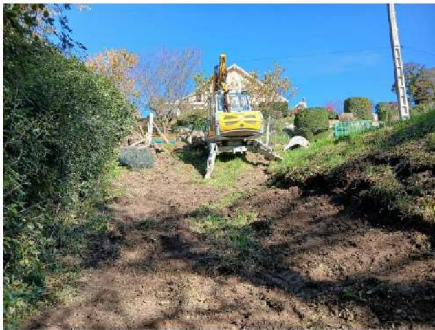
Pose de la conduite d'eau potable dans un talus
