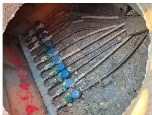
Vue sur l'arrivée d'un immeuble comprenant un regard avec un compteur de contrôle et un regard comprenant l'ensemble de compteurs individuels de l'immeuble
