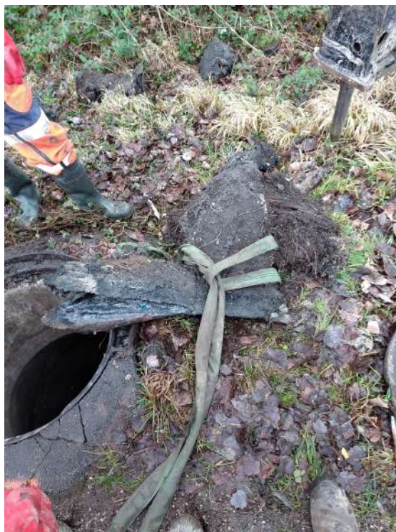
Entretien d'un réseau d'assainissement bouché par des racines
