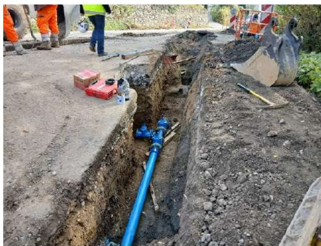
Pose de la conduite d'eau potable au droit du réservoir de Roche Bourg
