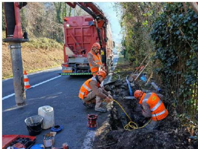
Condamnation de la conduite d'eau potable existante sous la RD avec création d'une vidange
