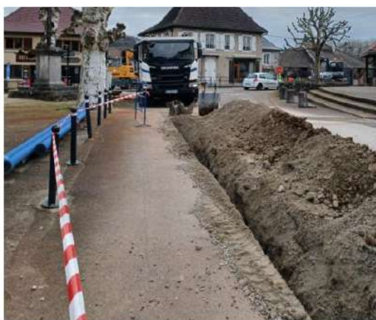
Pose du nouveau réseau d'assainissement au fil du chantier
