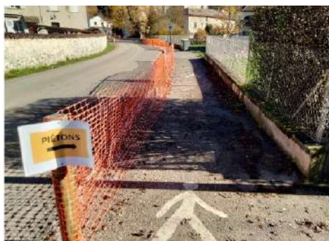
Aménagement d'un passage sécurisé en préparation des travaux
