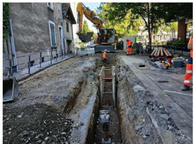
Pose du nouveau réseau d'assainissement au fil du chantier
