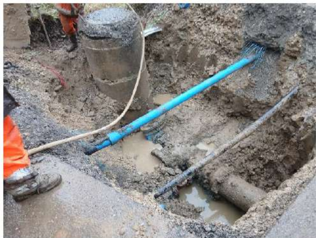
Vue sur les conduites d'eau potable neuve (à gauche) et ancienne (à droite)
