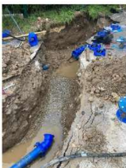
Raccordement de la canalisation – Impasse du Jardin
