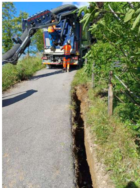
Tranchée de reprise d'un branchement d'eau chez un abonné (St-Etienne-de-Crossey)
