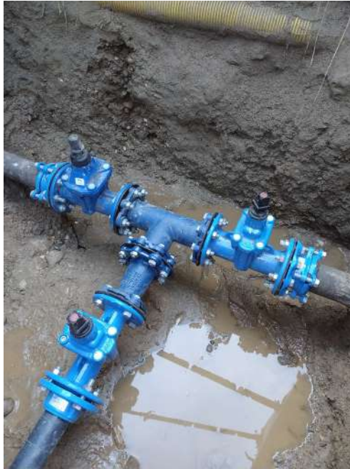
Installation Té 3 vannes DN125 sur une conduite en fonte à La Murette (CAPV)
