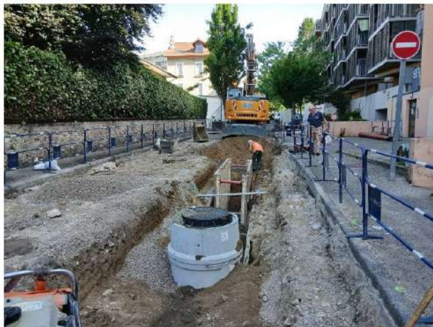
Pose du nouveau réseau d'assainissement au fil du chantier
