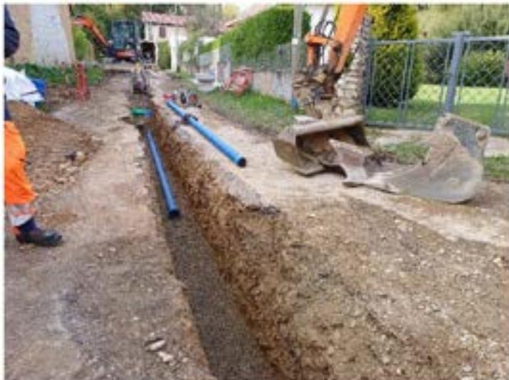
Pose de la conduite d'eau potable (en bleu) en tranchée
