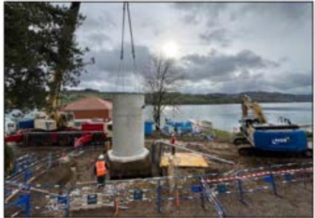
Grutage et pose de la cuve du poste
