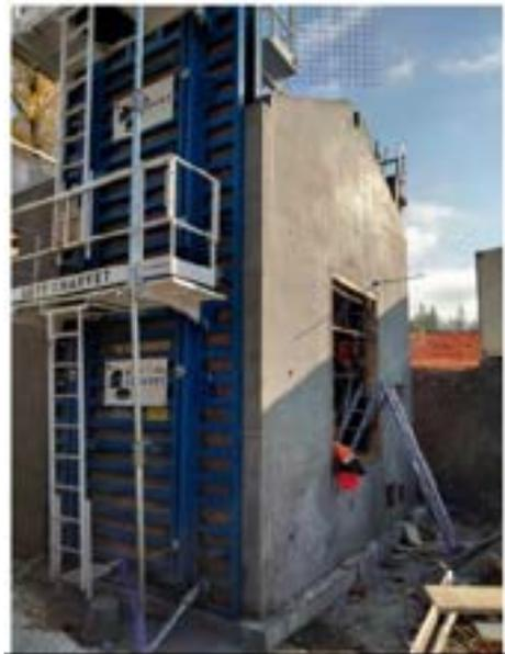
Élévation des voiles de la station de pompage
