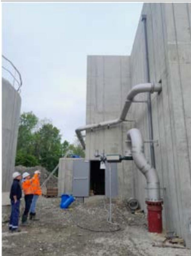
Pose des tuyauteries du Décanteur Lamellaire – Avril 2024
