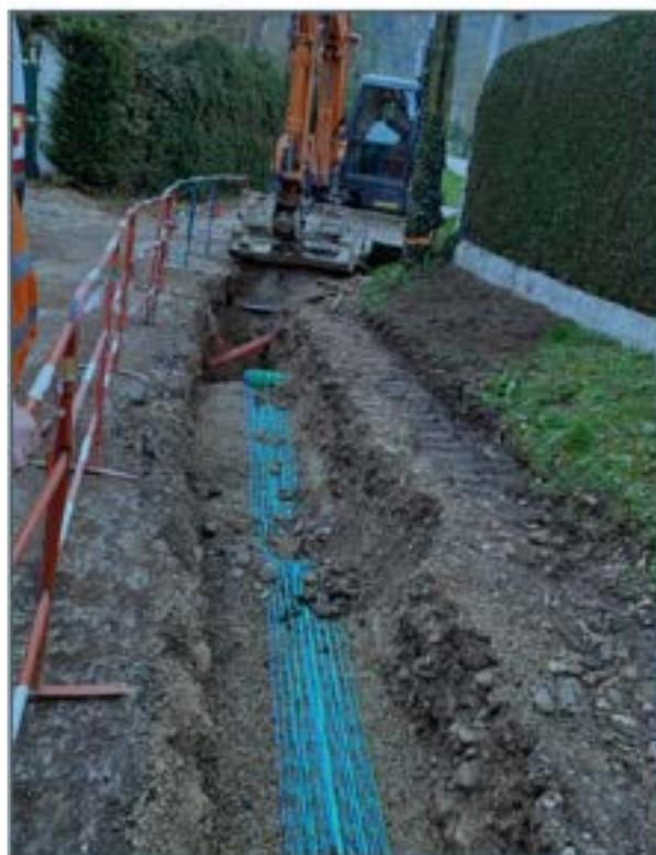
Remblaiement de la tranchée d'eau potable avec vue sur le grillage avertisseur
