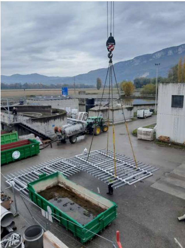
Pose des rampes d'injection d'air dans le bassin d'aération
