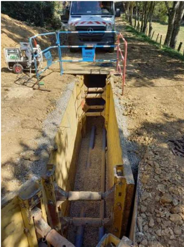
Vue sur la pose des conduites d'adduction et de distribution d'eau potable
