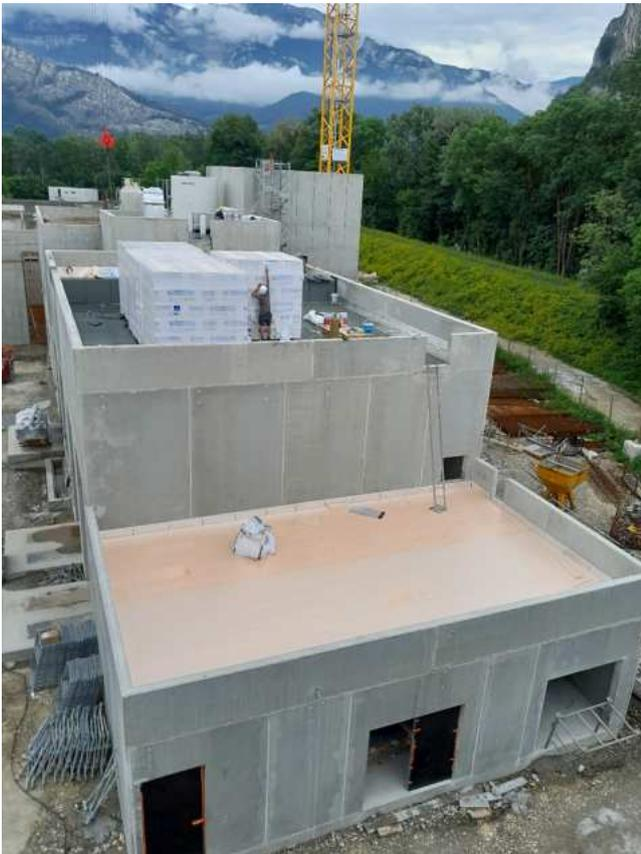
Construction du bâtiment de traitement des produits extérieurs (produits de curage, matière de vidange, graisses et boues extérieures) – Juin 2023
