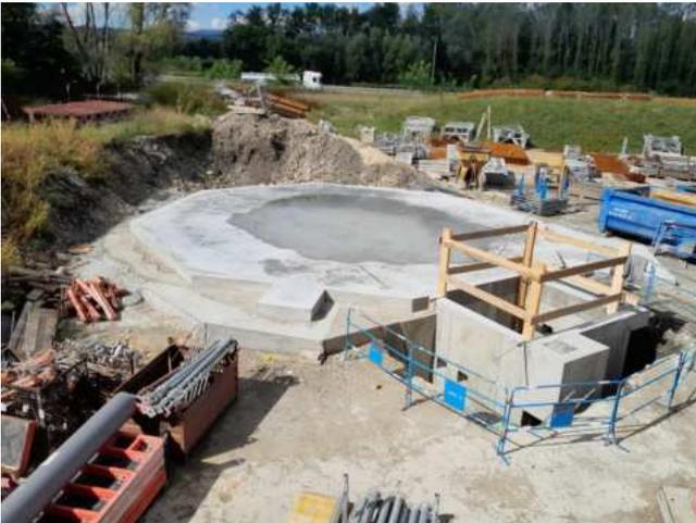
Réalisation de la dalle béton du Gazomètre
