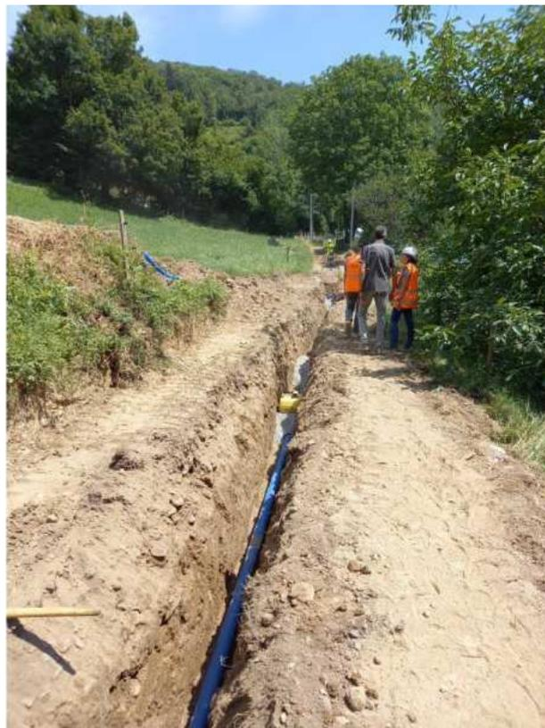
Vue sur la pose de la conduite d'adduction d'eau potable
