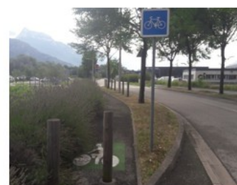
Centr'Alp : piste cyclable monodirectionnelle problème d'entretien et d'obstacle
