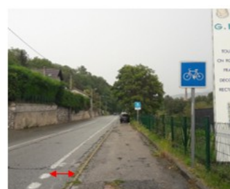
RD 592 (Voiron-St Jean de M.) : bande cyclable étroite sur une voie à fort trafic (~ 10 000 veh/j)
