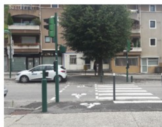
La Buisse : traversée matérialisée
