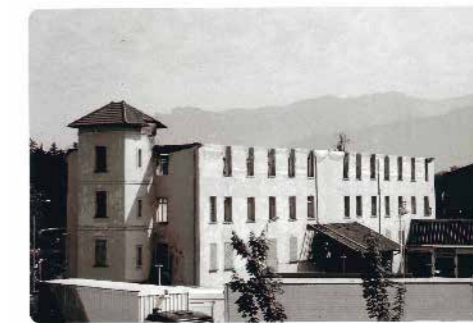
Le futur siège en travaux
